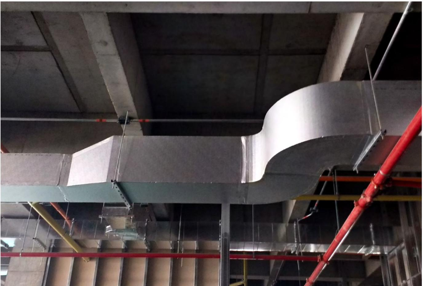
O Painel PIR-ALU são painéis para a construção de dutos de ar-condicionado, composto por uma espuma rígida de Poliisocianurato (PIR), revestida em ambas as faces com filme de alumínio multicamada, resultando em um produto excepcionalmente leve e rígido.
