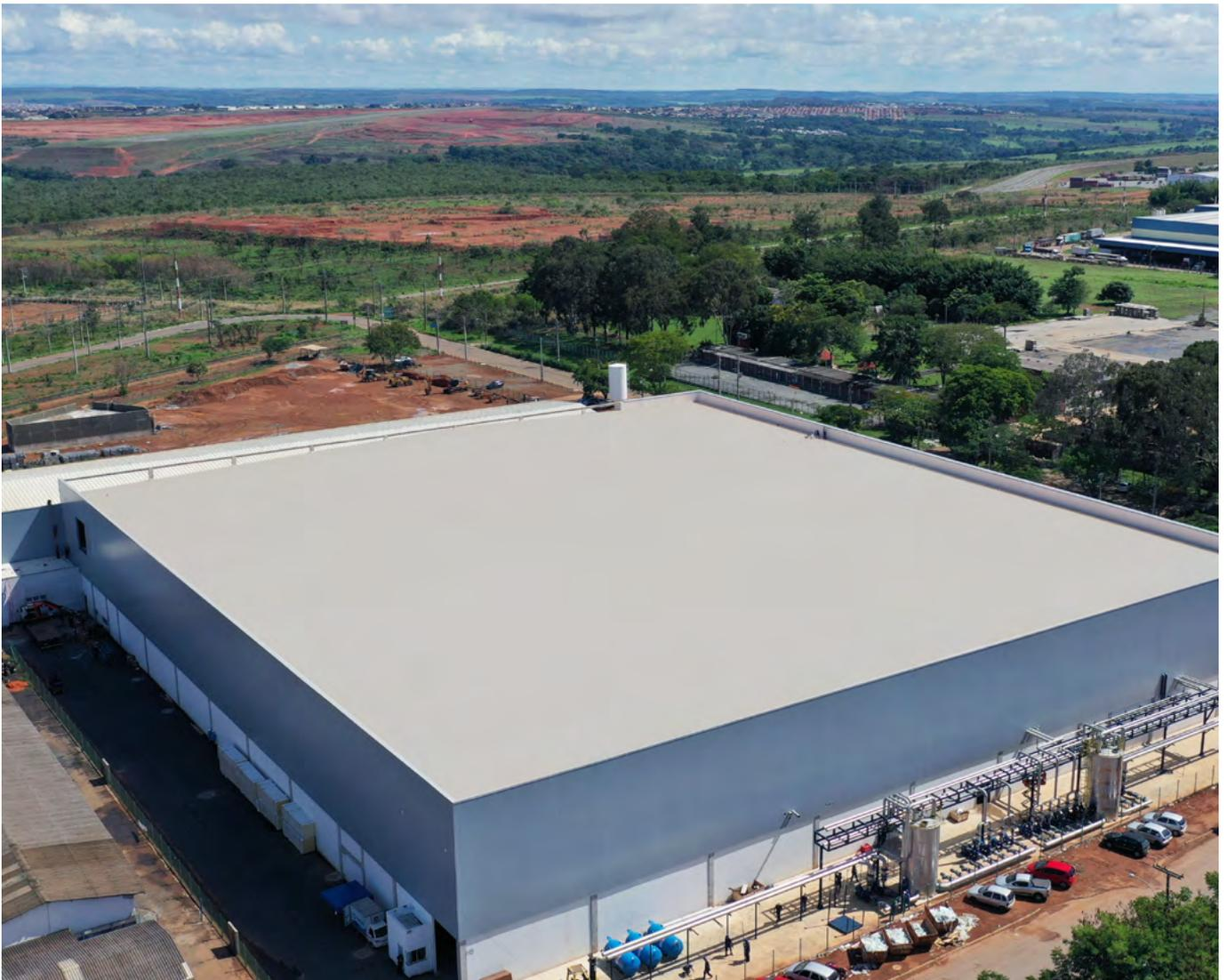
O sistema de cobertura KingDeck é um produto formado por uma Isotelha composta por aço na face interna, núcleo isotérmico em PIR AP e uma membrana PVC na face externa.
