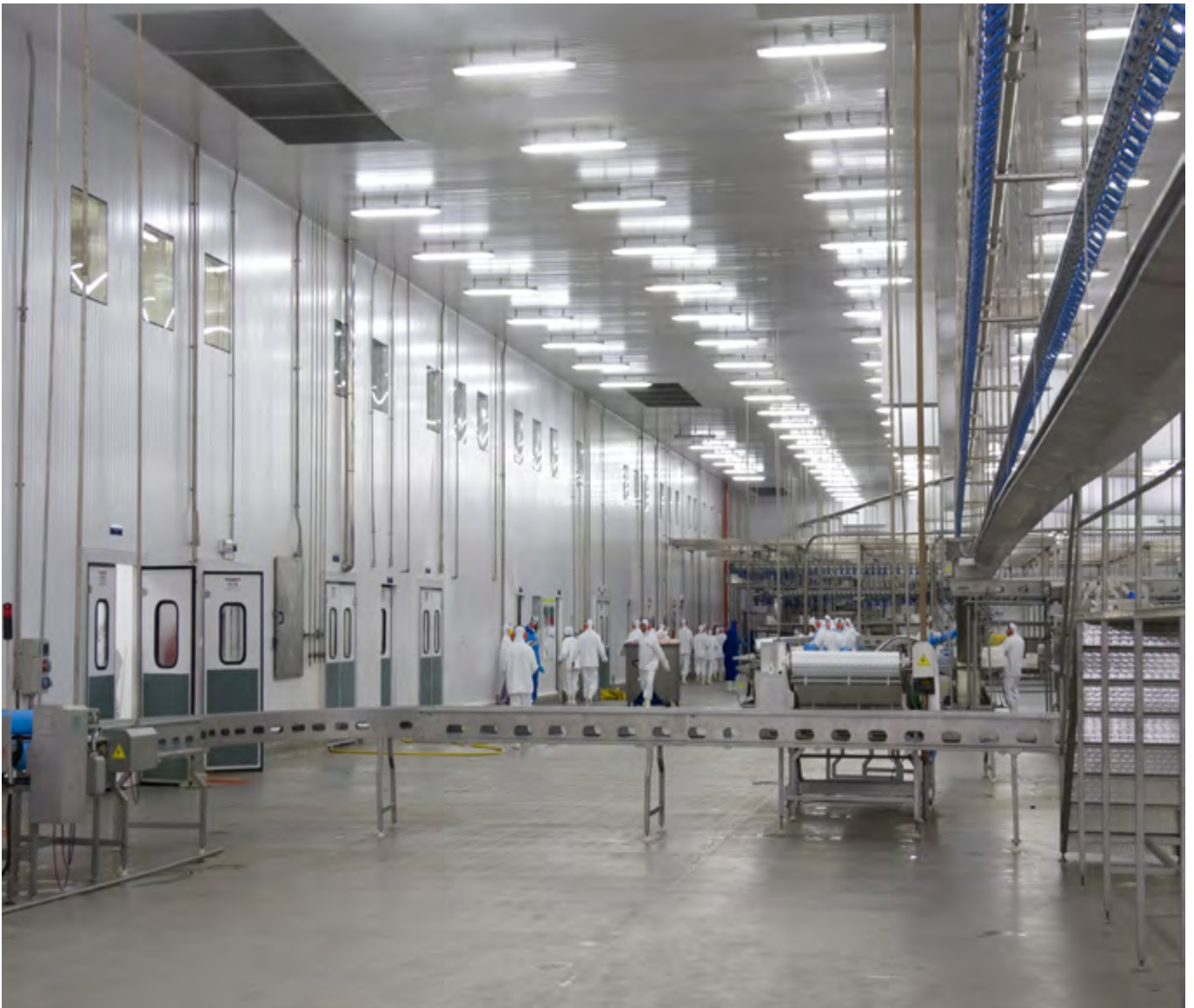
Frigorífico Sadia - Lucas do Rio Verde - MT
