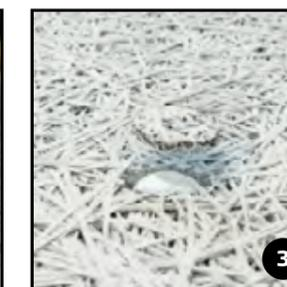
Corte a lâ de madeira e use-a para preencher o furo colada com o selante
