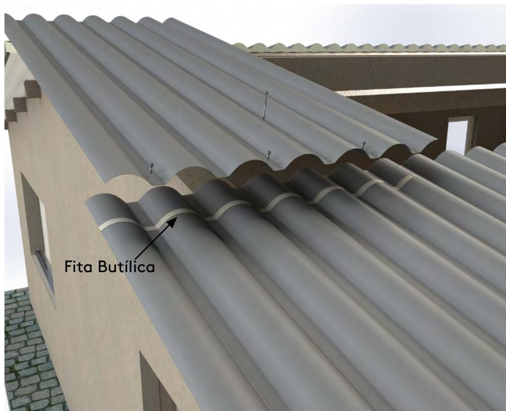
6. Utilizar os parafusos de costura para fixar o transpasse na telha abaixo, em seguida utilizar os parafusos de fixação. Consumo: 4 parafusos de costura por transpasse.
