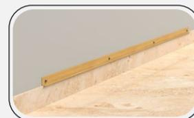
7. Realizar a fixação do perfil em 4 pontos na parede;
