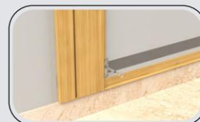
14. Instalar o primeiro perfil de Infinity Wall, utilizando o clipe, parafuso(s) e bucha(s). Seguir orientação de fixação do clipe do passo 12 acima, para instalação em ambientes internos ou externos;
