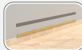
8. Aplicar a primeira linha da fita de espuma de PVC, cerca de 150mm do rodapé, em todo o comprimento onde serão instalados os perfis Infinity Wall;
