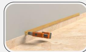
5. Iniciar a instalação dos materiais, instalando o acabamento inferior logo acima do rodapé, utilizando parafuso e bucha, portanto inicia-se realizando o furo na parede para alocar a bucha;
