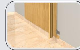
17. Antes de instalar o perfil de acabamento de fim de montagem, aplicar fita dupla face em pelo menos 5 pontos do perfil de acabamento com largura de 10cm espaçadas igualmente ou, se preferir, aplicar a fita dupla face ao longo de todo o comprimento do perfil. Feito isso, encaixar o acabamento final de montagem na última peça de Infinity Wall;
