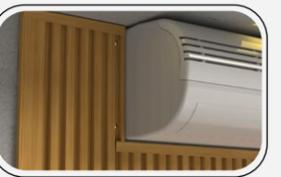
3. Após fixar a peça, colar o acabamento L 30x18 nas laterais da abertura.
