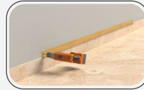
5. Iniciar a instalação dos materiais, instalando o acabamento inferior logo acima do rodapé, utilizando parafuso e bucha, portanto inicia-se realizando o furo na parede para alocar a bucha;
