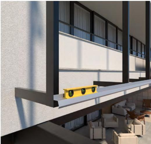
**Passo 2:** A montagem se inicia pelo alinhamento da primeira peça do Brise Venice, este é um passo importante pois toda montagem seguirá o nivelamento deste primeiro perfil.
