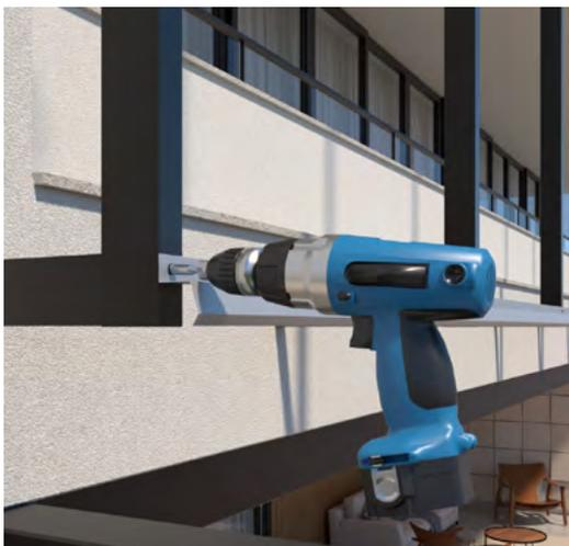
**Passo 3:** A fixação do Brise Venice deverá ser feita com um parafuso sextavado autobrocante por ponto de apoio, seguindo a autoportância máxima indicada para o produto.
