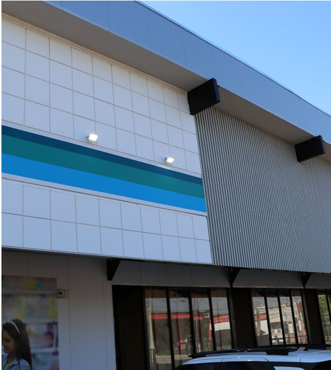
Drogaria Raia Cidade: Birigui, Estado: São Paulo Produto: 1169 m 2 de Isotelhas, 1034 m 2 de Painéis Frigo, 140 m 2 de Módulos Creative Wall 181 m 2 de Painéis Evolution, 96 m 2 de Perfis Concept Wall
