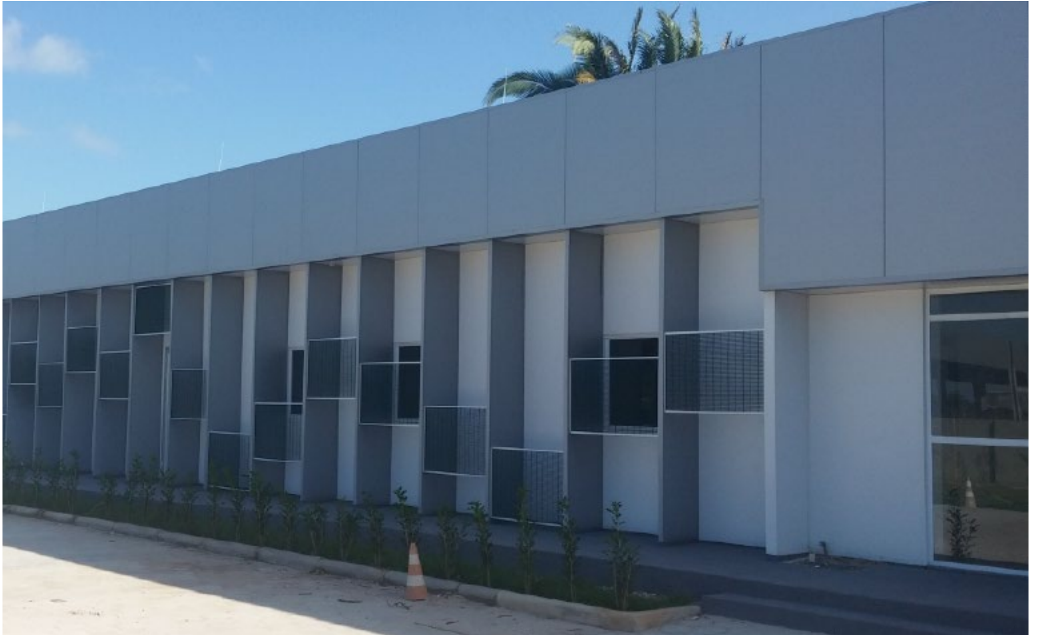
Posto de Saúde Vale Terminal Ponta da Madeira Cidade: São Luis, Estado: Maranhão
