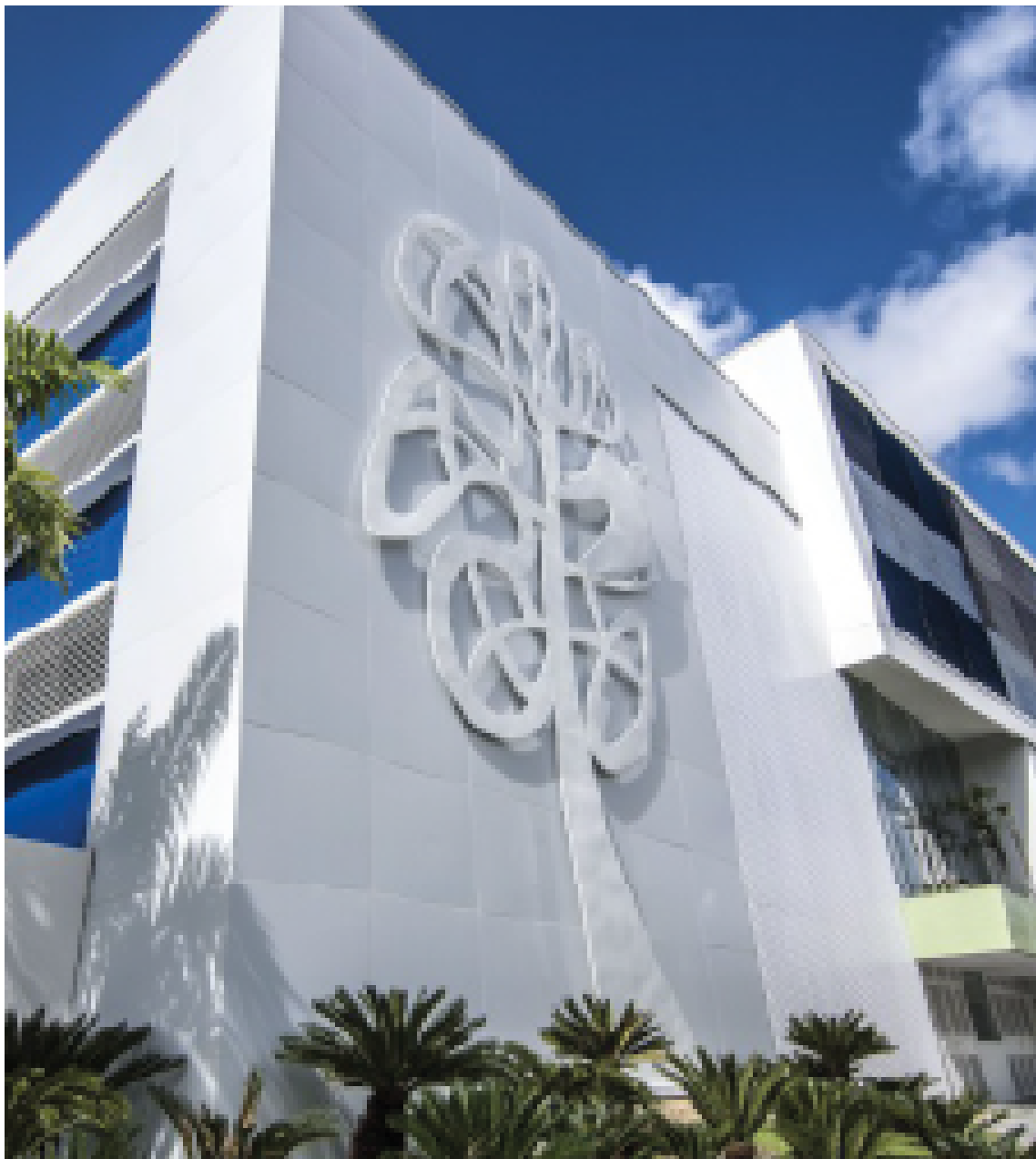
Colégio Fazer Crescer Cidade: Recife, Estado: Pernambuco Produto: 461 m² de Painéis Isofachada
