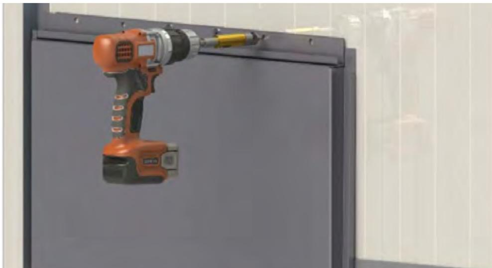
Rebitar os novos furos com a quantidade necessária de acordo com a posição dos pré-furos existentes no cassete, tipicamente a cada 150 mm.
