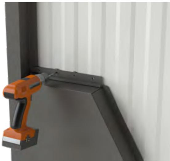
Montar primeiramente uma coluna de peças, respeitando o espaço livre de 2 mm entre elas:
