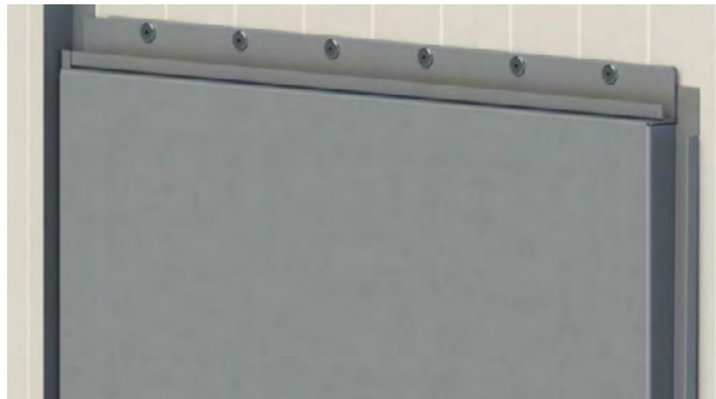
Posicionar a segunda peça garantindo um espaçamento de 2 mm entre o encaixe das peças para dilatação térmica. Sempre verificar o nivelamento das peças entre si e a marcação previamente feita e utilizar os espaçadores de 2 mm em todos os lados:
