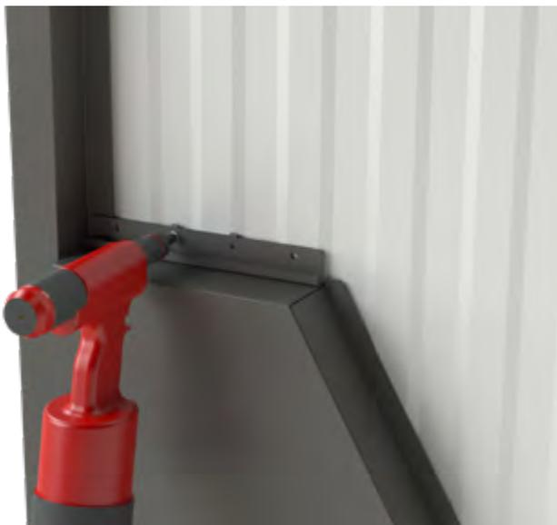
Após a conclusão do posicionamento, realizar o furo onde irão os rebites:
